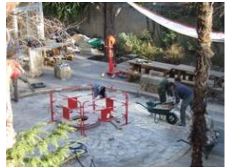
Figure 8 - Réaménagement de la cour
