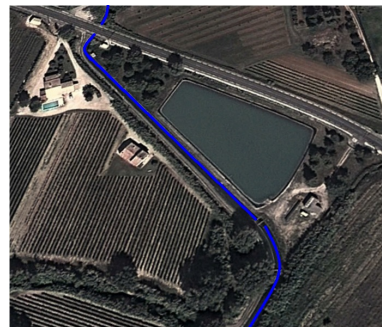
(c) Réservoir sur le Canal de Carpentras (source : G. BELAUD)
