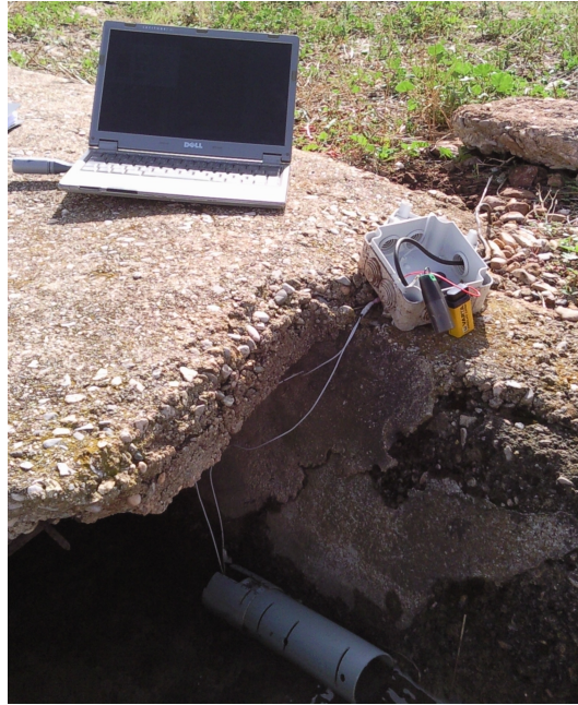
FIGURE 2.5 – Installation d'un contacteur
