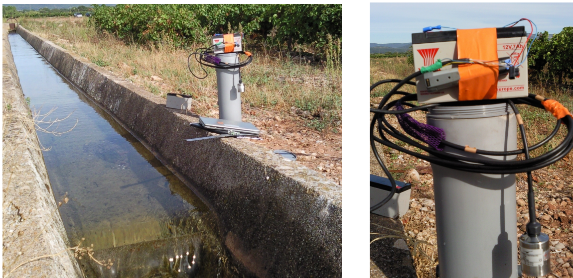
FIGURE 2.4 – Installation d'une sonde de pression
